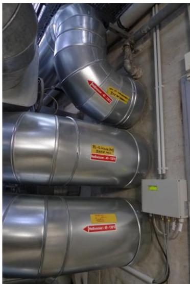
Misura di energia termica sulle condotte di condizionamento aria.
