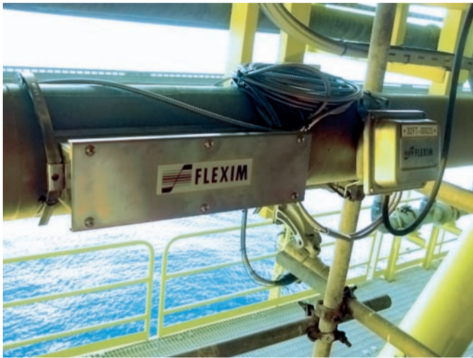
La tecnologia clamp-on di Flexim (montaggio completamente all'esterno delle tubazioni) utilizzata sulla piattaforma Gullfaks A ha eliminato i problemi di fermo impianto per riparazione e manutenzione
